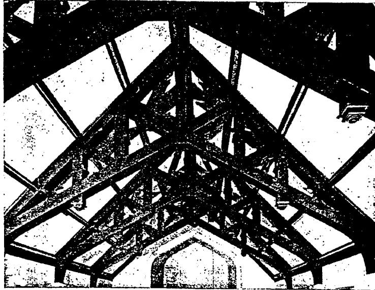
Fig 3-6. Scissors Truss
